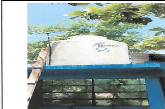
Foto 3: Instalación de Rotoplast con sus respectivos accesorios.
